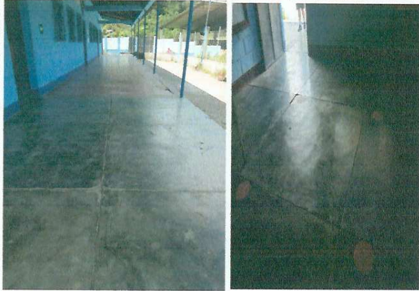
Foto1: Cambio de piso de torta de cemento a piso ceramico aula1,2,3 y corredor.
